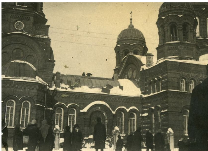
Разборка кровли храма
