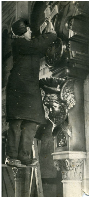
Демонтаж внутреннего убранства храма
